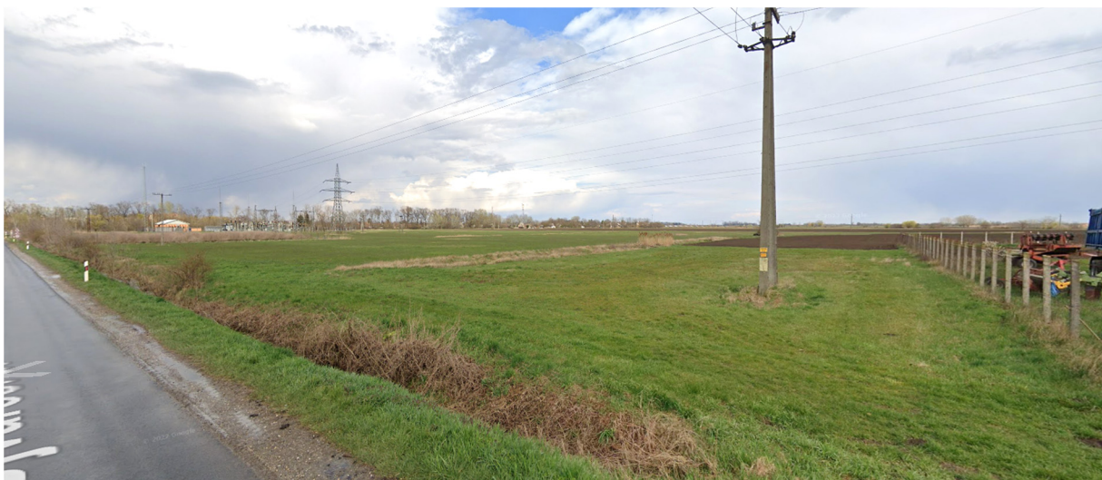
Naperőmű park területe, a Balmazújvárosi út felől.
