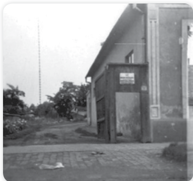
Az első mentőállomás bejárata a Köztársaság tér felől
