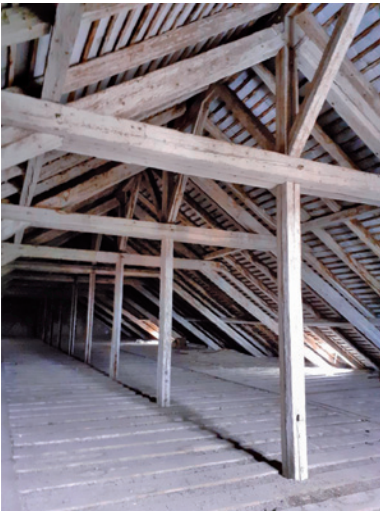
Az olasz, vagy függesztett tetőszerkezet a templomon.
