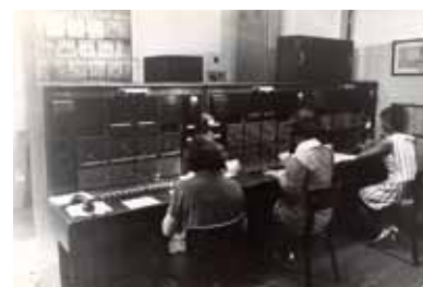
A nánási posta telefonközpontja egykoron
